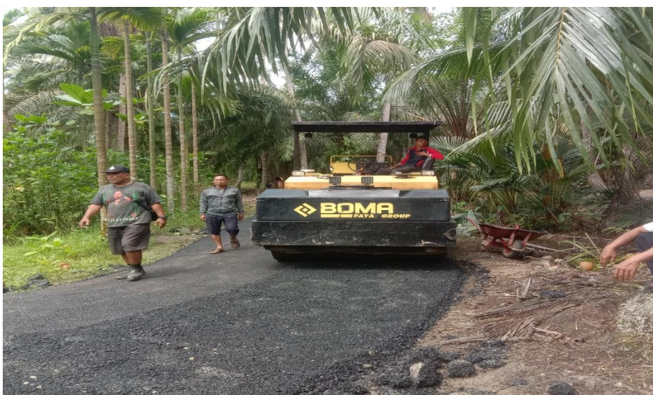
Gambar Pengaspalan Jalan dengan Hotmix Desa Baja Kuning Kec. Tanjung Pura
